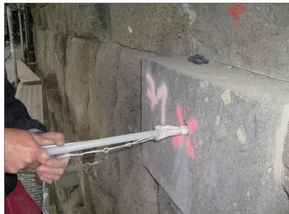
Einbau eines Nadelankers
