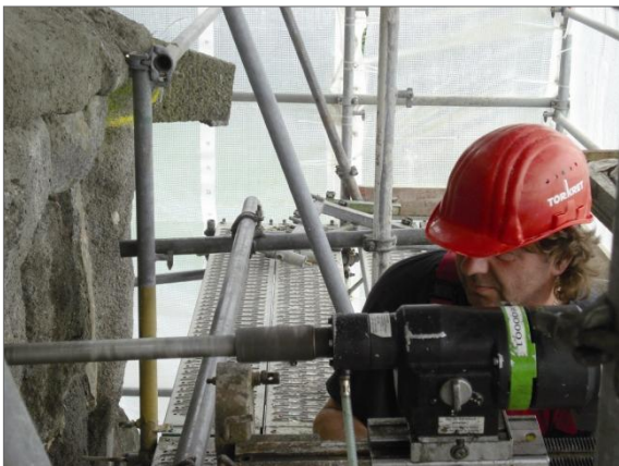
Erschütterungsfreie Kernbohrung
