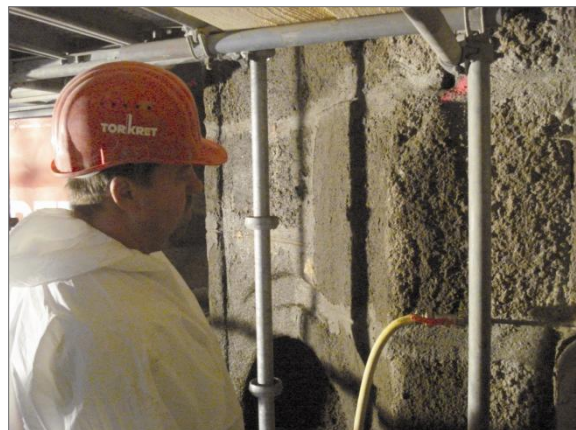
Injektion- und Verfestigung
