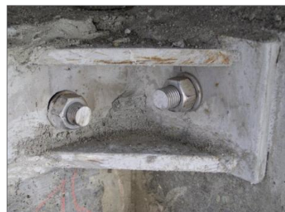
Einbau GEWI-Anker
